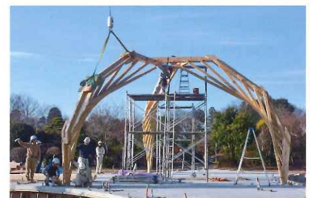
基本となる3つの組柱の施工段階。
